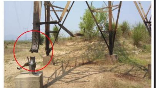
ကေစီ ၂၃၀ သထုံ-မော်လမြိုင် ဓာတ်အားလိုင်း တာဝါတိုင် တစ်တိုင် မိုင်းခွဲဖျက်ဆီးခံရ၍ ခြေထောက်တစ်ချောင်း ပျက်စီးနေပုံ။
