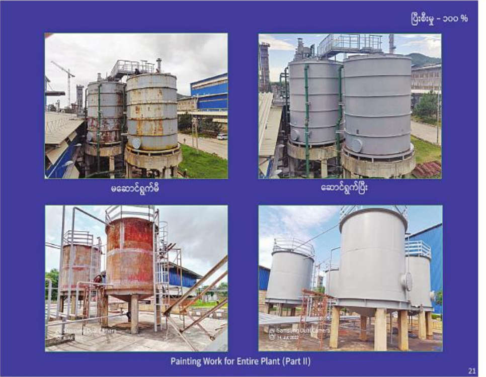
ပြီးစီးမှု - ၁၀၀ % မဆောင်ရွက်မီ ဆောင်ရွက်ပြီး Painting Work for Entire Plant (Part II)
