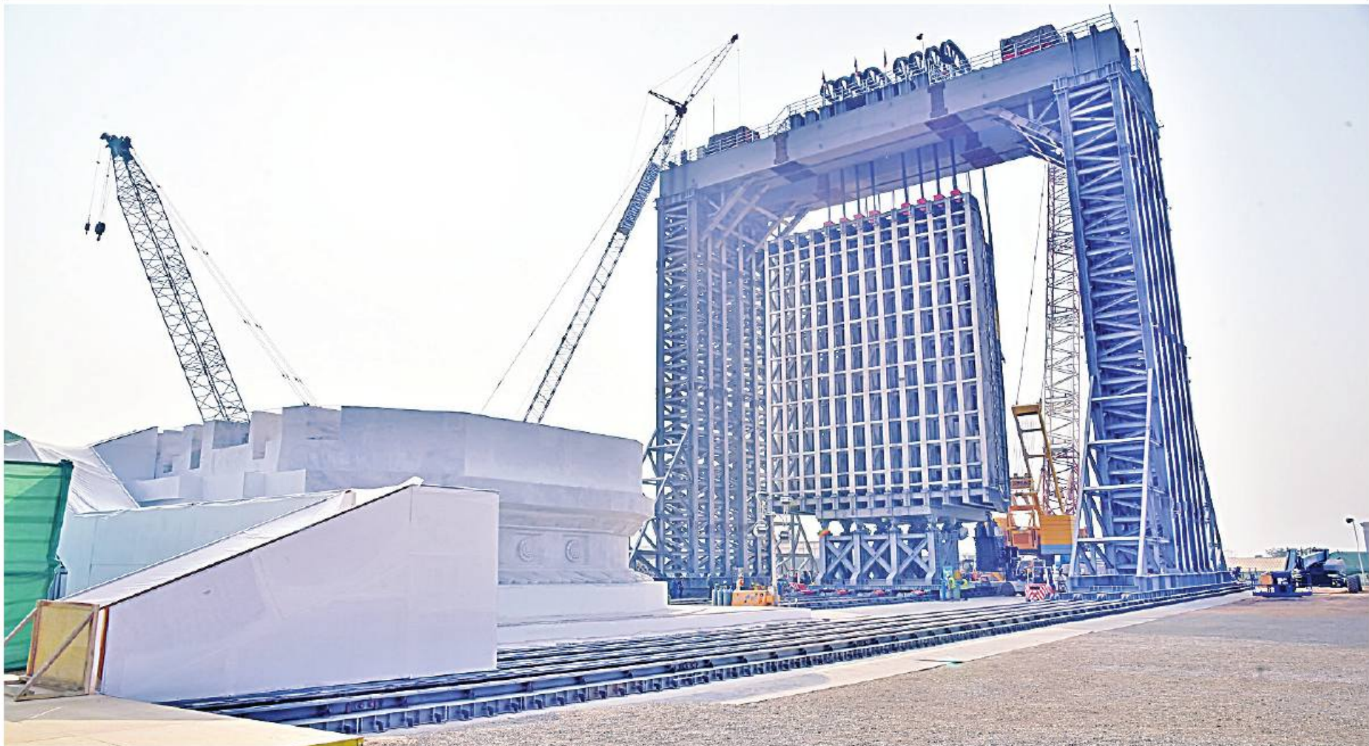
မာရဝိဇယပုဒ္ဂလ်ပွားတော်မြတ်ကြီး၏ ဆင်းတုတော်အပိုင်း(၁/၂/၃)တို့ကို တွဲဆက်ထားသည့် ဆင်းတုတော်အစိတ်အပိုင်းကြီးအား ရတနာပလ္လင်တော်ထက်သို့ ပင့်ဆောင်နိုင်ရန် ပင့်ထောင်ခြင်းလုပ်ငန်းများ ဆောင်ရွက်ခဲ့ရာ ဇန်နဝါရီ ၂၉ ရက် နံနက် ၉ နာရီတွင် ၉၀ ဒီဂရီအထိ အမြင့်အားဖြင့် ၇၅ ဒဿမ ၅ ပေအထိ ပင့်ထောင်ပူဇော်ပြီးစီးမှုကို တွေ့ရစေ၍။
