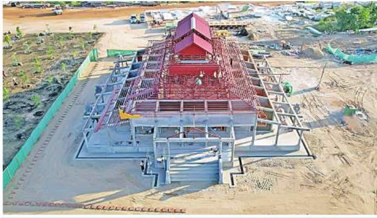
၂၀၂၂ ခုနှစ် နိုဝင်ဘာလတွင် ကျောင်းဆောင်တော် တည်ဆောက်ပြီးစီးမှုအခြေအနေကို တွေ့ရစဉ်။
