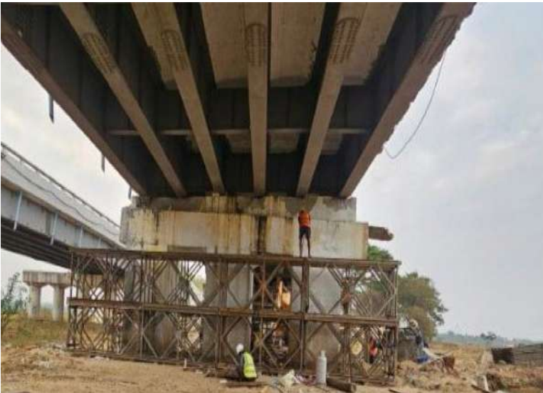
ငလျင်ဘေးဒဏ်ကြောင့် ထိခိုက်ပျက်စီးခဲ့သည့် ဆွာချောင်းတံတားအား ငြိမ်းထောက်ခြင်းလုပ်ငန်း ဆောင်ရွက်နေမှုကို တွေ့ရစဉ်။
