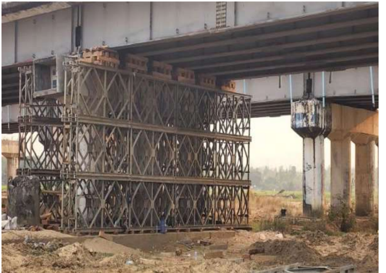
ငလျင်ဘေးဒဏ်ကြောင့် ထိခိုက်ပျက်စီးခဲ့သည့် ဆွာချောင်းတံတားအား ငြိမ်းထောက်ခြင်းလုပ်ငန်း ဆောင်ရွက်နေမှုကို တွေ့ရစဉ်။
