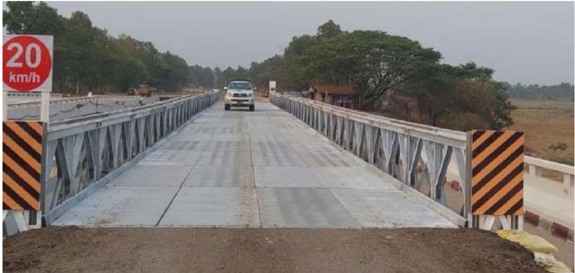
ငလျင်ဘေးဒဏ်ကြောင့် ထိခိုက်ပျက်စီးခဲ့သည့် ဆွာချောင်းတံတား ပြင်ဆင်ဆောင်ရွက်လျက်ရှိပြီး ငါးတန်အောက် မော်တော် ယာဉ်များ ဖြတ်သန်းသွားလာနေမှုကို တွေ့ရစဉ်။
