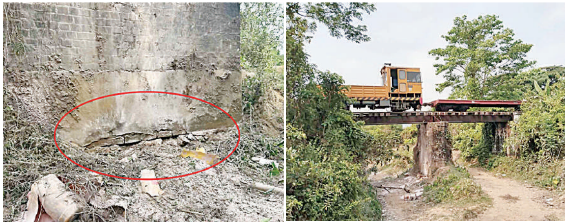
KNLA အဖွဲ့မှ အကြမ်းဖက်မှု လိုလားသူများနှင့် PDF အမည်ခံအကြမ်းဖက်သမားများက မိုင်းထောင်ဖောက်ခွဲမှုကြောင့် တံတားအောက်ခြေတိုင်ပျက်စီးခဲ့မှုနှင့် မီးရထားများစမ်းသပ်သွားလာမှုတို့ကို တွေ့ရစဉ်။
