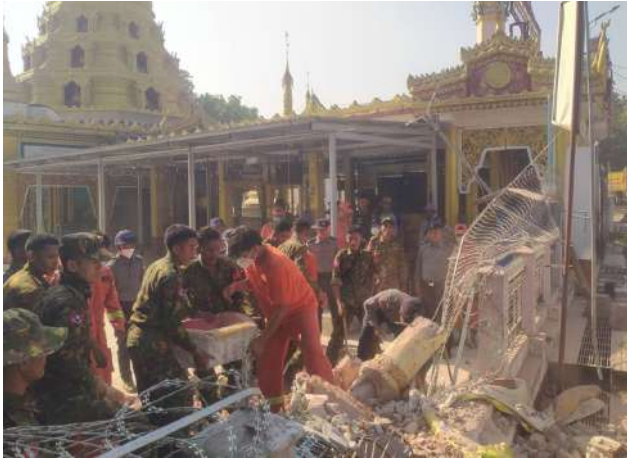
ငလျင်ဒဏ်ကြောင့် တပ်ကုန်းမြို့နယ် မိုးဗ်ကောင်းဘုရားကြီး၌ ကူညီကယ်ဆယ်ရေးဆောင်ရွက်ပေးစဉ်။
