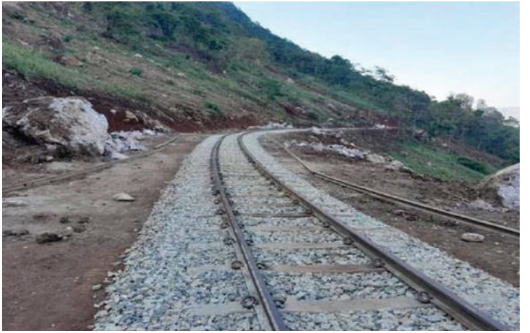
ခွေးရုပ်-ဆင်တောင်ကြား တောင်ပြိုမြေများကို ဖယ်ရှားရှင်းလင်းဆောင်ရွက်ပြီးစီးမှုကို တွေ့ရစဉ်။
