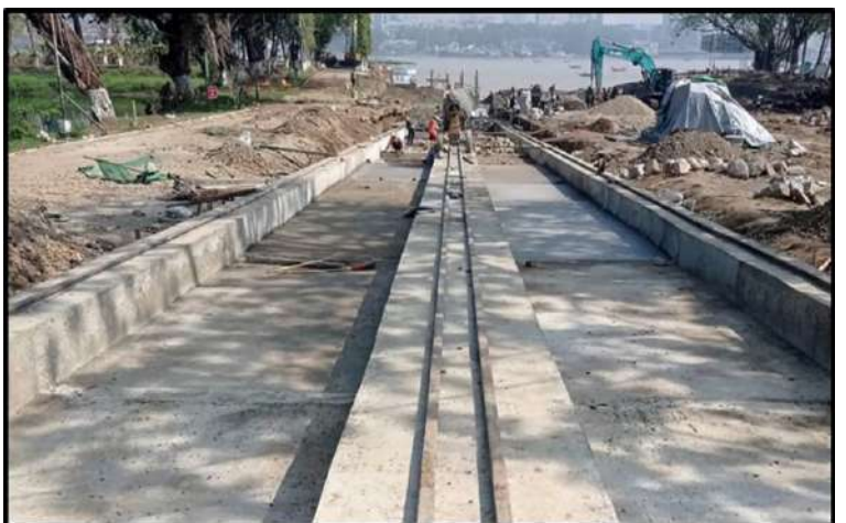
အမှတ်(၁)လွန်းလမ်းအဟောင်းကို ပြုပြင်မွမ်းမံမှုများ ဆောင်ရွက်နေမှုကို တွေ့ရစဉ်။
