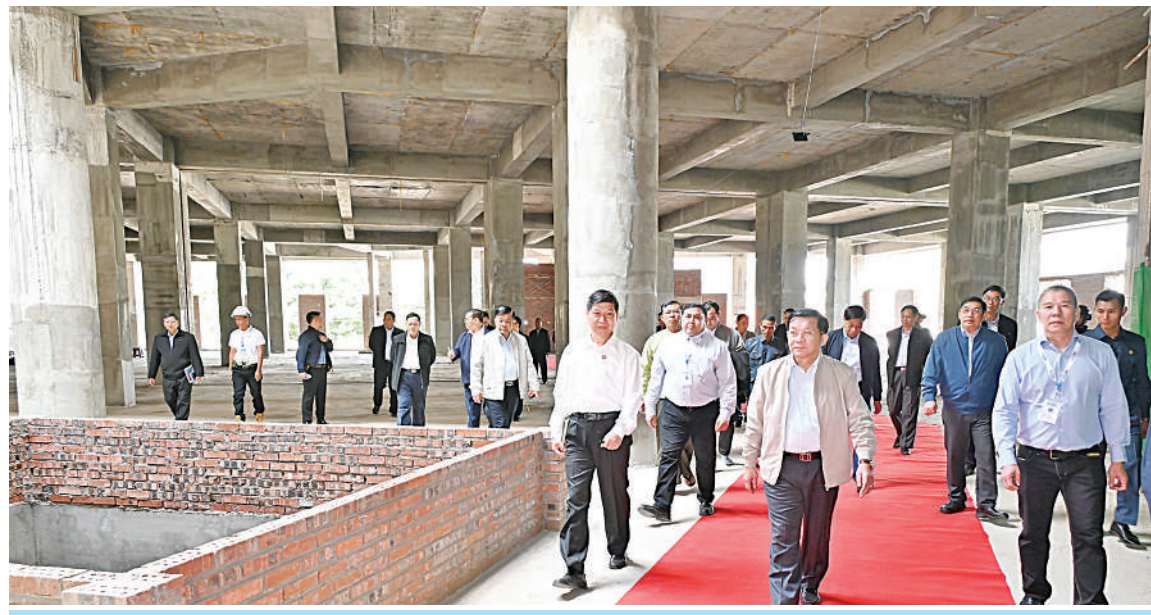
နိုင်ငံတော်စီမံအုပ်ချုပ်ရေးကောင်စီဥက္ကဋ္ဌ နိုင်ငံတော်ဝန်ကြီးချုပ် ဗိုလ်ချုပ်မှူးကြီးမင်းအောင်လှိုင် ပြင်ဦးလွင်မြို့ သုမင်္ဂလာဈေး(ညံတောဈေး) ခြောက်ထပ်အဆင့်မြှင့်ဈေးသစ်တည်ဆောက်ရေးစီမံကိန်းအတွင်း လုပ်ငန်းဆောင်ရွက်နေမှုအခြေအနေများကို လှည့်လည်ကြည့်ရှုစစ်ဆေးစဉ်။
