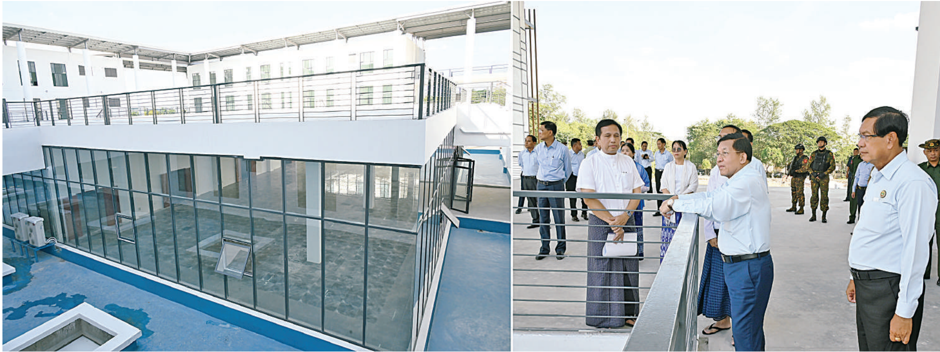
နိုင်ငံတော်စီမံအုပ်ချုပ်ရေးကောင်စီဥက္ကဋ္ဌ နိုင်ငံတော်ဝန်ကြီးချုပ် ဗိုလ်ချုပ်မှူးကြီးမင်းအောင်လှိုင် ရန်ကုန်အနောက်ပိုင်းနည်းပညာတက္ကသိုလ် ပင်မသုံးထပ်စာသင်ဆောင်အသစ် တည်ဆောက်ပြီးစီးမှုအခြေအနေများကို လိုက်လံကြည့်ရှုစစ်ဆေးစဉ်။
