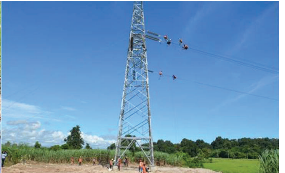
မိုးသည်းထန်စွာရွာသွန်း၍ ရေကြီးရေလျှံမှုကြောင့် ကေစီ ၂၃၀ ရွှေမြို့-နေပြည်တော်(၂) ဓာတ်အားလှိုင်းရှိ တာဝါတိုင် လေးတိုင်နှင့် ကေစီ ၂၃၀ သာစည်-ရွှေမြို့ ဓာတ်အားလှိုင်းရှိ တာဝါတိုင် ငါးတိုင် ပြိုလဲပျက်စီးခဲ့ပြီး ပြန်လည်ပြုပြင်တည်ဆောက်ခြင်း လုပ်ငန်းများကို အရှိန်အဟုန်မြှင့်တင်ဆောင်ရွက်ခဲ့ရာ ကေစီ ၂၃၀ သာစည်-ရွှေမြို့ ဓာတ်အားလှိုင်းရှိ တာဝါတိုင်များ တည်ဆောက်ပြီးစီး၍ ဓာတ်အားပြန်လည်ပို့လွှတ်ဖြန့်ဖြူးပေးနိုင်ခဲ့ပြီး ကျန်ရှိသည့် ကေစီ ၂၃၀ ရွှေမြို့-နေပြည်တော်(၂) ဓာတ်အားလှိုင်းရှိ တာဝါတိုင်များ ပြန်လည်တည်ဆောက်ခြင်းလုပ်ငန်းကို ဆောင်ရွက်လျက်ရှိရာ အောက်တိုဘာလ ဒုတိယပတ်အတွင်းပြီးစီးနိုင်ရေးနှင့် ဓာတ်အားအမြန်ပို့လွှတ်ပေးနိုင်ရေး ကြိုးပမ်းဆောင်ရွက်လျက် ရှိကြောင်း သတင်းရရှိသည်။ (သတင်းစဉ်)
