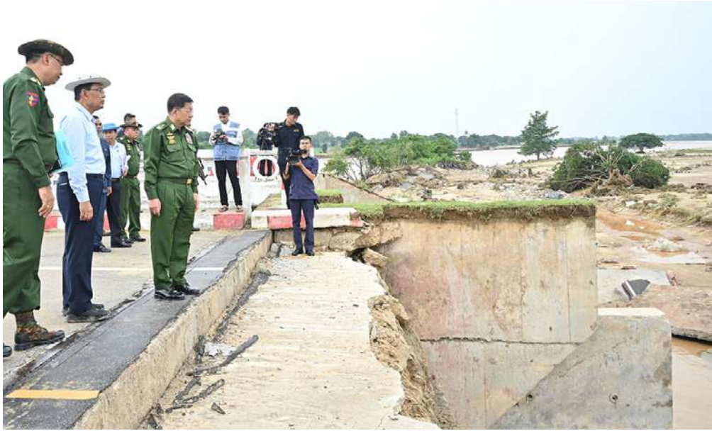
နိုင်ငံတော်စီမံအုပ်ချုပ်ရေးကောင်စီဥက္ကဋ္ဌ တပ်မတော်ကာကွယ်ရေးဦးစီးချုပ် ဗိုလ်ချုပ်မှူးကြီးမင်းအောင်လှိုင် ဆင်သေချောင်းတစ်လျှောက် ရုတ်တရက် ရေကြီးရေလျှံခြင်းများကြောင့် သိုက်ချောင်းတံတား(ဆင်သေချောင်းကူး) တံတားကမ်းကပ်ခုံများပျက်စီးခြင်း၊ ချဉ်းကပ်လမ်းရေတိုက်စား၍ လမ်းတာပေါင်ပျက်စီးခြင်း၊ တံတားရေလယ်တိုင်(Pier)များ နိမ့်ကျခြင်းများဖြစ်ပေါ်ခဲ့သဖြင့် လမ်းပန်းဆက်သွယ်မှုမပြတ်တောက်စေရေး ဘေလီတံတားထိုး၍ ပြင်ဆင်ဆောင်ရွက်နေမှုအခြေအနေများကို သွားရောက်ကြည့်ရှုစစ်ဆေးစဉ်။
