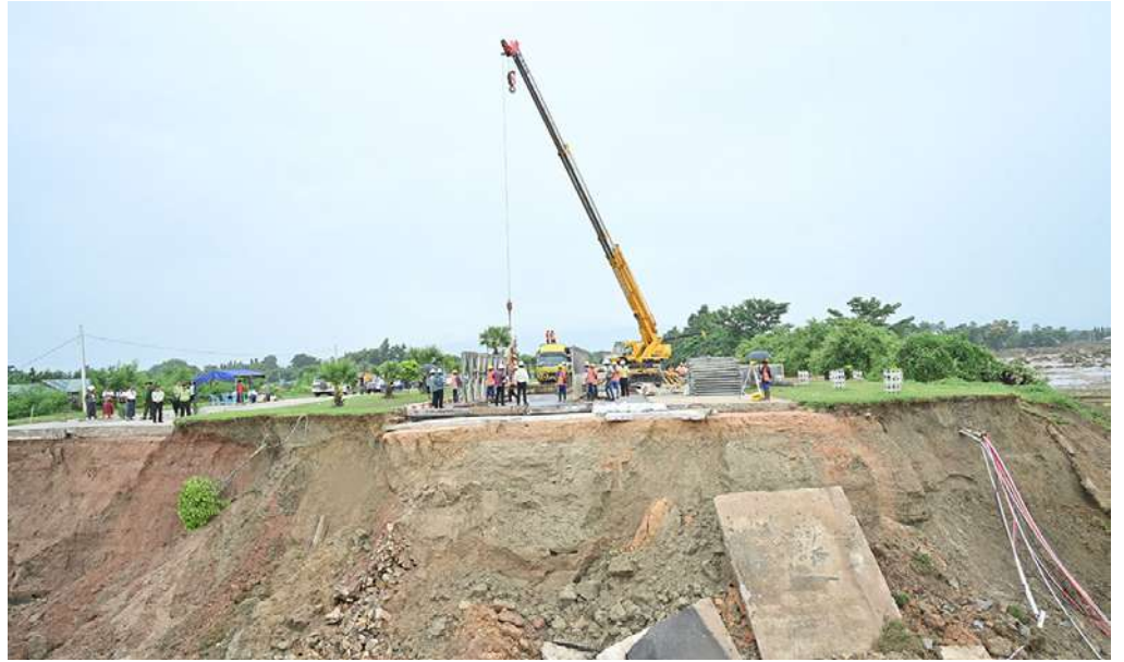
နိုင်ငံတော်စီမံအုပ်ချုပ်ရေးကောင်စီဥက္ကဋ္ဌ တပ်မတော်ကာကွယ်ရေးဦးစီးချုပ် ဗိုလ်ချုပ်မှူးကြီးမင်းအောင်လှိုင် ဆင်သေချောင်းတစ်လျှောက် ရုတ်တရက် ရေကြီးရေလျှံခြင်းများကြောင့် သိုက်ချောင်းတံတား(ဆင်သေချောင်းကူး) တံတားကမ်းကပ်ခုံများပျက်စီးခြင်း၊ ချဉ်းကပ်လမ်းရေတိုက်စား၍ လမ်းတာပေါင်ပျက်စီးခြင်း၊ တံတားရေလယ်တိုင်(Pier)များ နိမ့်ကျခြင်းများဖြစ်ပေါ်ခဲ့သဖြင့် လမ်းပန်းဆက်သွယ်မှုမပြတ်တောက်စေရေး ဘေလီတံတားထိုး၍ ပြင်ဆင်ဆောင်ရွက်နေမှုအခြေအနေများကို သွားရောက်ကြည့်ရှုစစ်ဆေးစဉ်။
