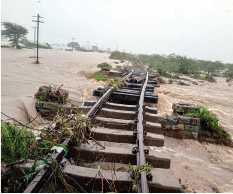
သာစည်-ရွှေညောင်လမ်းပိုင်း လှိုင်းတက်နှင့် ဘုရားငါးဆူကြား တံတားရေတိုက်စားမှုအခြေအနေကို တွေ့ရစဉ်။
