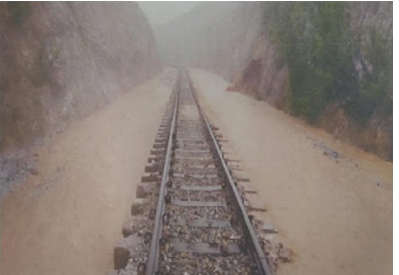
ရန်ကုန်-မန္တလေးရထားလမ်းပိုင်း ရှမ်းရွာနှင့်ပျော်ဘွယ်ဘူတာအကြား ရထားလမ်းတာပေါင်များရေတိုက်စားပြီး ထူးပေါက်မှုအခြေအနေကို တွေ့ရစဉ်။
