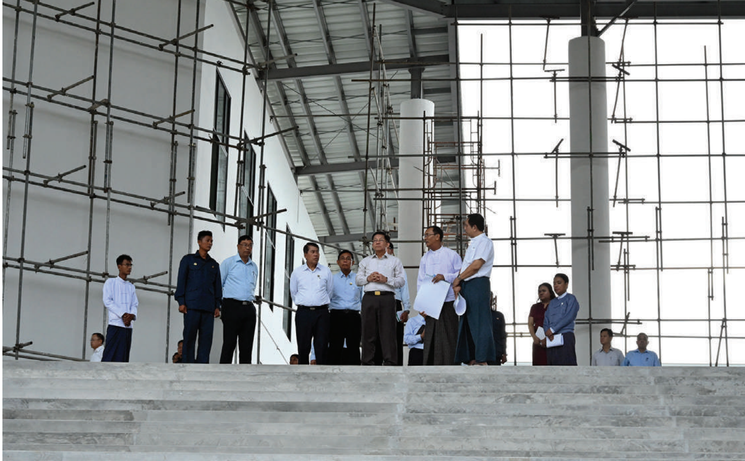
နိုင်ငံတော်စီမံအုပ်ချုပ်ရေးကောင်စီဥက္ကဋ္ဌ နိုင်ငံတော်ဝန်ကြီးချုပ် ဗိုလ်ချုပ်မှူးကြီးမင်းအောင်လှိုင် ရန်ကုန်အနောက်ပိုင်းနည်းပညာတက္ကသိုလ်အတွင်း စာသင်ဆောင်အသစ် ဆောက်လုပ်နေမှုများကို လှည့်လည်ကြည့်ရှုစစ်ဆေးစဉ်။
