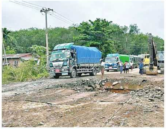
မွန်ပြည်နယ် သထုံမြို့နယ် ကရင်လေးဆိပ်ကျေးရွာအနီးရှိ တံတားအား မော်တော်ယာဉ်များ ဖြတ်သန်းသွားလာနိုင်ရေး ယာယီတံတား ဆောင်ရွက်ပေးထားမှုကို တွေ့ရစဉ်။
