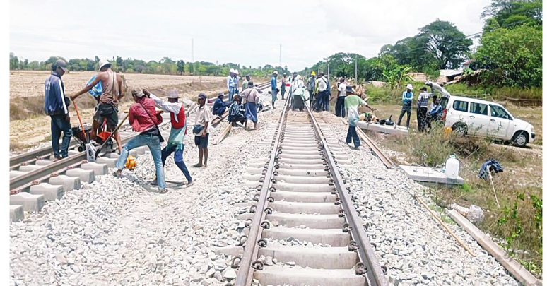
ရန်ကုန်-မန္တလေး ရထားလမ်းပိုင်းအတွင်း ဖြူးမြို့နယ် ညောင်ပင်သာနှင့် ကညွတ်ကွင်းဘူတာကြား ရထားလမ်းပိုင်းအား ဝန်ထမ်းများက ပြန်လည်ဖြုတ်ခြင်းနေ့ကို တွေ့ရစဉ်။
