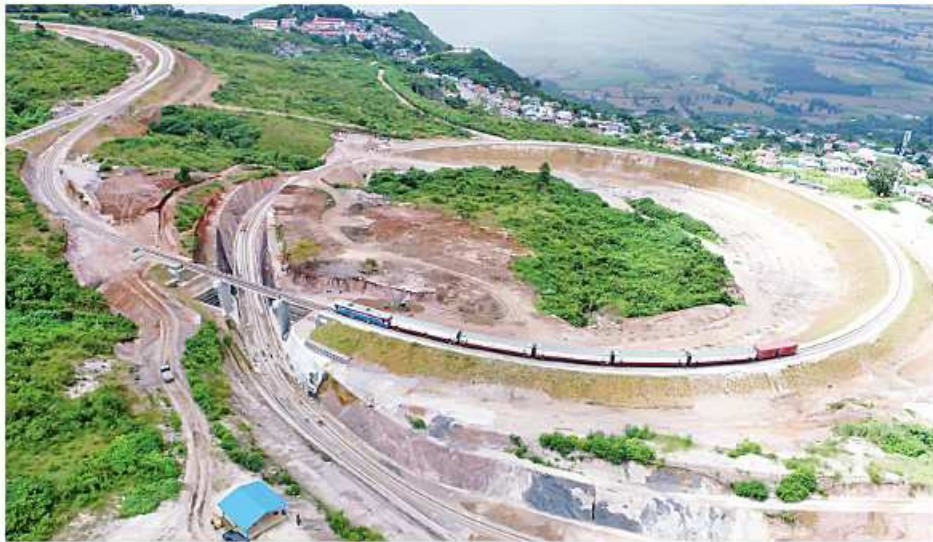
တောင်ကြီး-ရွှေညောင်ရထားလမ်း အဆင့်မြှင့်တင်ခြင်းလုပ်ငန်းမှ ထိသိမ်အိုင်းပတ်တည်ဆောက်ထားမှုမှတ်တမ်း။
