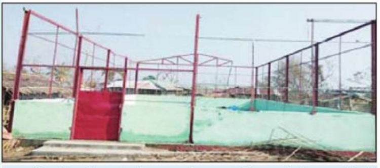
ကျောက်တော်မြို့နယ် ကံသုံးဆင့်ကျေးရွာတွင် ကျေးရွာဖွံ့ဖြိုးရေးလုပ်ငန်းများဆောင်ရွက်ရာ၌အသုံးဝင်သည့် ဘက်စုံသုံးခန်းမပျက်စီးမှုကိုပြုပြင်ခြင်းဆောင်ရွက်မိတွေ့ရစဉ်။
