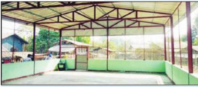
ကျောက်တော်မြို့နယ် ကံသုံးဆင့်ကျေးရွာတွင် ကျေးရွာဖွံ့ဖြိုးရေးလုပ်ငန်းများဆောင်ရွက်ရာ၌အသုံးဝင်သည့် ဘက်စုံသုံးခန်းမပြုပြင်ဆောင်ရွက်ပြီးစီးမှုအခြေအနေကိုတွေ့ရစဉ်။
