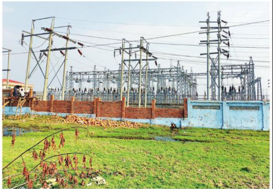
လျှပ်စစ်စွမ်းအားဝန်ကြီးဌာနမှ ကျွမ်းကျင်လုပ်သားများဖြင့် ပြန်လည်ထူထောင်ရေးလုပ်ငန်းများဆောင်ရွက်မှုကြောင့် ၂၀၂၃ ခုနှစ် မေလ ၂၅ ရက်တွင် ၂၃၀ ကေစီ ပင်မဓာတ်အားခွဲရုံ ၉၀ ရာခိုင်နှုန်းအထိ ပြီးစီးမှုကိုတွေ့ရစဉ်။
