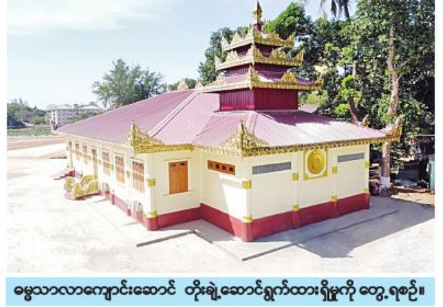
ဓမ္မသာလာကျောင်းဆောင် တိုးချဲ့ဆောင်ရွက်ထားရှိမှုကို တွေ့ရစဉ်။
