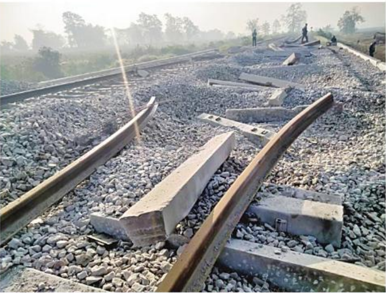
မိုင်းဖောက်ခွဲခံရမှုကြောင့် ရန်ကုန်-မန္တလေးရထားလမ်းပိုင်း ပိန်းစလုပ်နှင့်ကျောက်တံစားဘူတာအကြား တံတားအမှတ်(၁၄၅)ပေါ်တွင် ရထားလမ်းပျက်စီးဆုံးရှုံးမှုကို တွေ့ရစဉ်။
