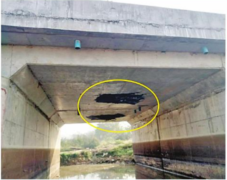
မိုင်းဖောက်ခွဲခံရမှုကြောင့် ရန်ကုန်-မန္တလေးရထားလမ်းပိုင်း ပိန်းစလုပ်နှင့်ကျောက်တံစားဘူတာအကြား တံတားအမှတ်(၁၄၅) ကြမ်းခင်းပျက်စီးဆုံးရှုံးမှုကို တွေ့ရစဉ်။
