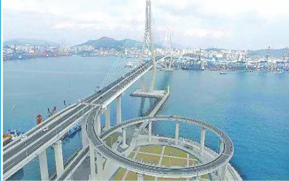
ကိုရီးယားနိုင်ငံမှ သံမက်ကြိုးဆိုင် (Cable-Stayed)တံတားအမျိုးအစားဖြစ်သည့် Bukhang တံတားအား မြင်ရပုံ။(ဆင်ခြေလျှောက်တံတားတွင် လျှောစောက် ၈ ရာခိုင်နှုန်းရှိပါသည်)
