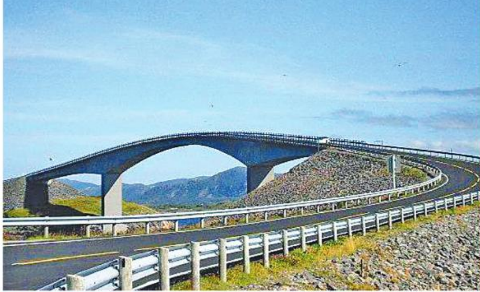
နော်ဝေနိုင်ငံမှ ကြိုတင်အားဖြည့်သံကူကွန်ကရစ်(PSC Box)ကြိုးတံတားအမျိုးအစားဖြစ်သည့် Stroseisumdet တံတားအားမြင်ရပုံ။(ပင်မတံတားတွင် လျှောစောက် ၈ ရာခိုင်နှုန်းရှိပါသည်)
