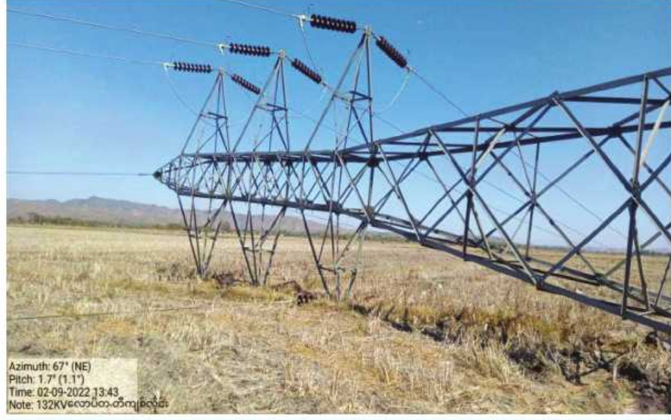
၁၃၂ ကေစီ ဘီလူးချောင်း(၂)-တီကျစ် ဓာတ်အားလိုင်းအား ဖျက်ဆီးထားမှုကို တွေ့ရစဉ်။
