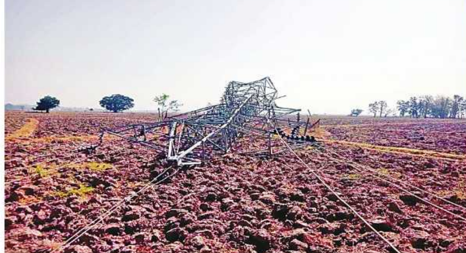
၁၃၂ ကေစီ ဘီလူးချောင်း(၂)-တီကျစ်ဓာတ်အားလိုင်း ဖျက်ဆီးခံရသည့် တာဝါတိုင်အမှတ်(၁၀၁၊၁၀၂၊၁၀၃၊၁၀၄၊၁၀၅)ပြိုလဲပျက်စီးနေသည့် မှတ်တမ်းဓာတ်ပုံ။
