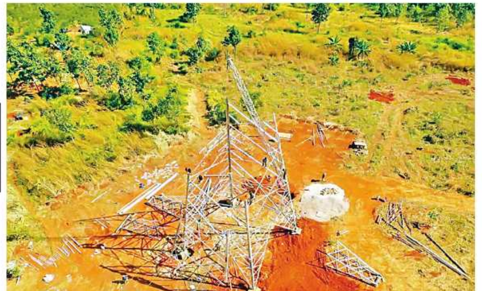
၁၈-၁၁-၂၀၂၁ ရက်တွင် ပြုလုပ်ပျက်စီးခဲ့သည့် ကေစီ ၂၃၀ ဘီလူးချောင်း(၂)- ရွှေမြို့ဓာတ်အားလိုင်း တာဝါတိုင်အမှတ်(၁၂၁)ကို ပြန်လည်ပြုပြင်နေသည့် မှတ်တမ်းဓာတ်ပုံ။
