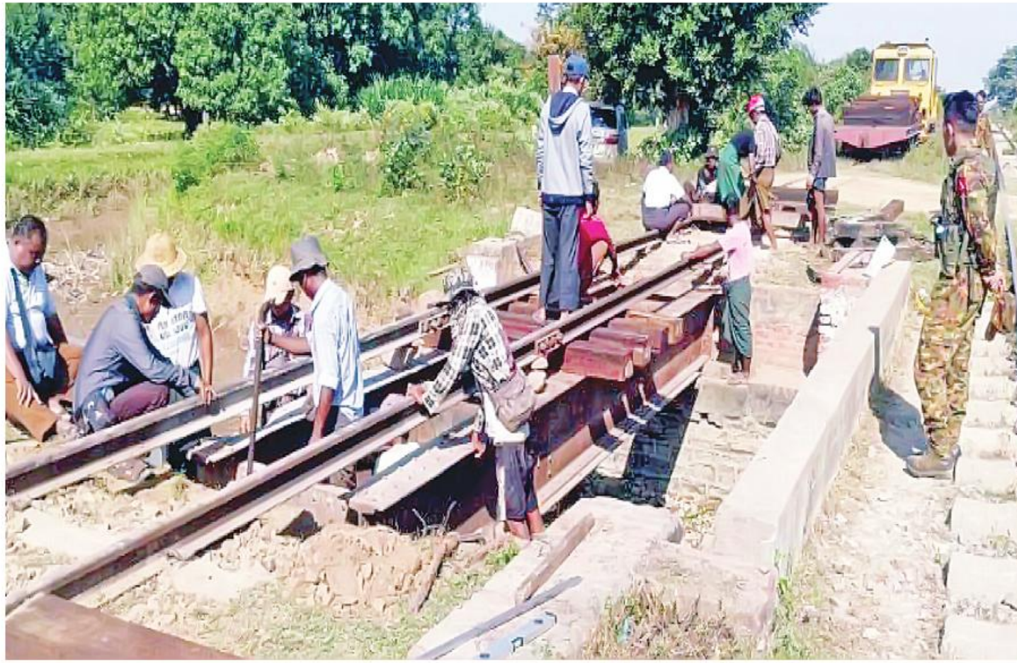
ရန်ကုန်-မန္တလေးရထားလမ်းပိုင်းအတွင်း မင်းစုဘူတာနှင့် ကျောက်ဆည်ဘူတာကြား ရထားလမ်းတံတားအနီး PDFအမည်ခံအကြမ်းပက်သမားများက မိုင်းထောင်ဖောက်ခွဲပျက်ဆီးထားမှုကြောင့် ယုတ်စီးခဲ့သည့်ရထားလမ်းကို ပြန်လည်ပြုပြင်ဆောင်ရွက်နေစဉ်။
