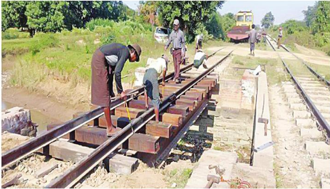
ရန်ကုန်-မန္တလေးရထားလမ်းအတွင်း မင်းရတုတာနှင့် ကျောက်ဆည်ဘူတာအကြား မိုင်တိုင်အမှတ် ၃၇၃/၃ ရှိ ၄ အကြား တံတားအမှတ် ၇၃၆ အနီးတွင် PDF အမည်ခံအကြမ်းဖက်သမားများက မိုင်းခွဲပျက်ဆီးထားခြင်းကြောင့် ပျက်စီးခဲ့သည့် ရထားလမ်းကို ပြန်လည်ပြုပြင်နေစဉ်။
