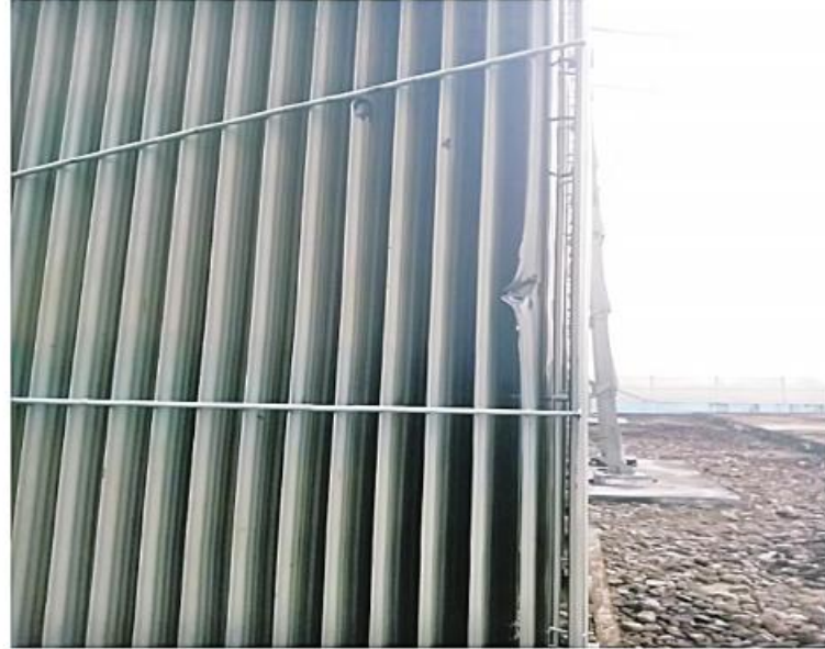
50 MVA အအေးခံကိရိယာ ပေါက်ပြဲမှုမှတ်တမ်းဓာတ်ပုံ။
