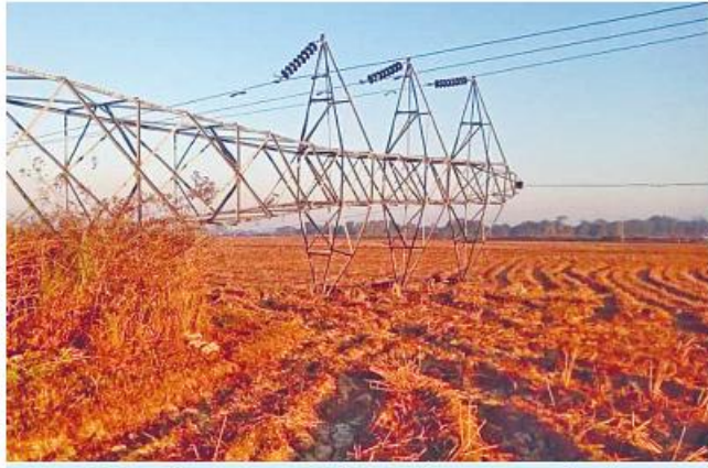
အကြမ်းဖက်သမားများပျက်ဆီးခဲ့သည့် ၁၃၂ ကေဗီ ဘီလူးဇောင်း(၂)-တီကျစ်နစ်ထပ်ဓာတ်အားလိုင်း တာဝါတိုင်အမှတ်(၁၁၅) ဖြိုလဲပျက်စီးခဲ့သည့်မှတ်တမ်းဓာတ်ပုံ။
