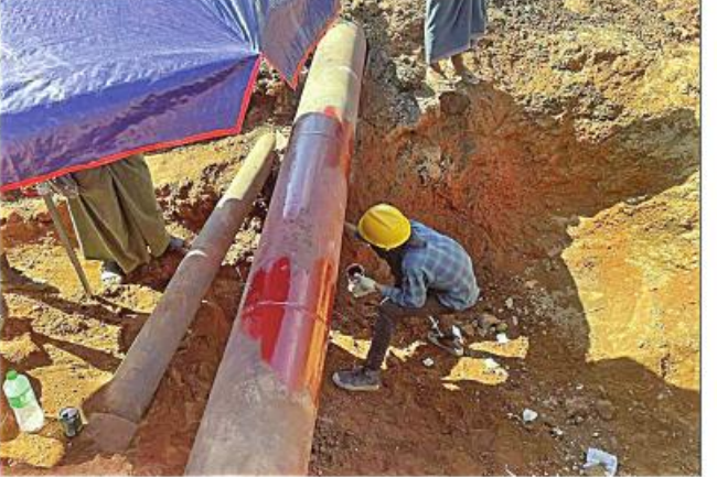
အကြမ်းဖက်သမားများ မိုင်းထောင်ဖောက်ခွဲပျက်ဆီးထားသည့် သဘာဝဓာတ်ငွေ့သုံးလျှပ်စစ်ဓာတ်အားပေးစက်ရုံများသို့ ပို့လွှတ်သည့် သဘာဝဓာတ်ငွေ့ပိုက်လိုင်းများကို မြန်မာ့ရေနံနှင့်သဘာဝဓာတ်ငွေ့လုပ်ငန်းဝန်ထမ်းများက ပြန်လည်ပြုပြင်နေမှု မှတ်တမ်းဓာတ်ပုံ။
