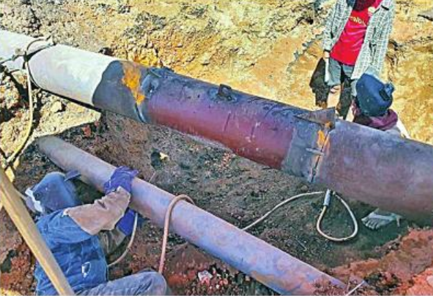
အကြမ်းဖက်သမားများ မိုင်းထောင်ဖောက်ခွဲပျက်ဆီးထားသည့် သဘာဝဓာတ်ငွေ့သုံးလျှပ်စစ်ဓာတ်အားပေးစက်ရုံများသို့ ပို့လွှတ်သည့် သဘာဝဓာတ်ငွေ့ပိုက်လိုင်းများကို မြန်မာ့ရေနံနှင့်သဘာဝဓာတ်ငွေ့လုပ်ငန်းဝန်ထမ်းများက ပြန်လည်ပြုပြင်နေမှု မှတ်တမ်းဓာတ်ပုံ။
