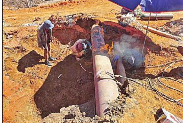
အကြမ်းဖက်သမားများ မိုင်းထောင်ဖောက်ခွဲပျက်ဆီးထားသည့် သဘာဝဓာတ်ငွေ့သုံးလျှပ်စစ်ဓာတ်အားပေးစက်ရုံများသို့ ပို့လွှတ်သည့် သဘာဝဓာတ်ငွေ့ပိုက်လိုင်းများကို မြန်မာ့ရေနံနှင့်သဘာဝဓာတ်ငွေ့လုပ်ငန်းဝန်ထမ်းများက ပြန်လည်ပြုပြင်နေမှု မှတ်တမ်းဓာတ်ပုံ။
