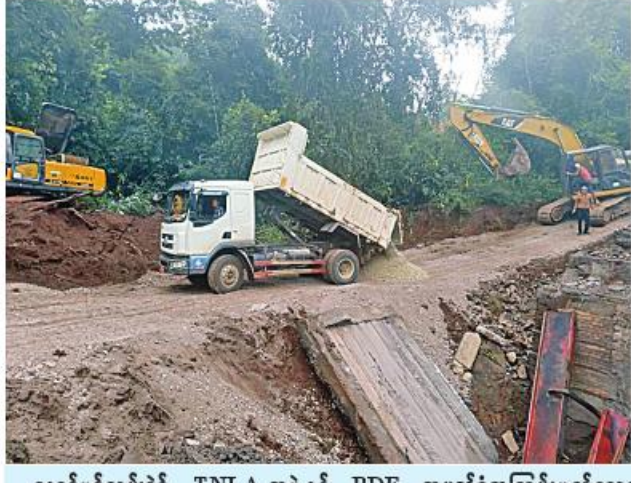
နောင်ပစ်လမ်းခွဲ၌ TNLA အဖွဲ့နှင့် PDF အမည်ခံအကြမ်းဖက်သောင်းကျန်းသူများ မြေဖြတ်ကျင်းများတူး၍ ဖျက်ဆီးထားရှိမှုကို လုံခြုံရေး တပ်ဖွဲ့ဝင်များက ပြန်လည်ပြုပြင်ရှင်းလင်းဆောင်ရွက်နေမှုနှင့် ဆောင်ရွက်ပြီးစီးမှုကို တွေ့ရစဉ်။
