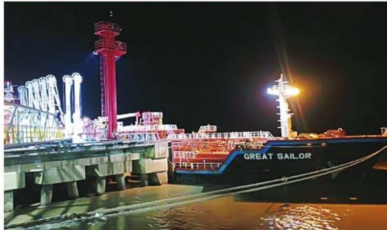
Brighter Energy Terminal(Thilawar) ၌ MT-Great Sailor သင်္ဘောဆိုက်ကပ်ထားမှုကို တွေ့ရစဉ်။
