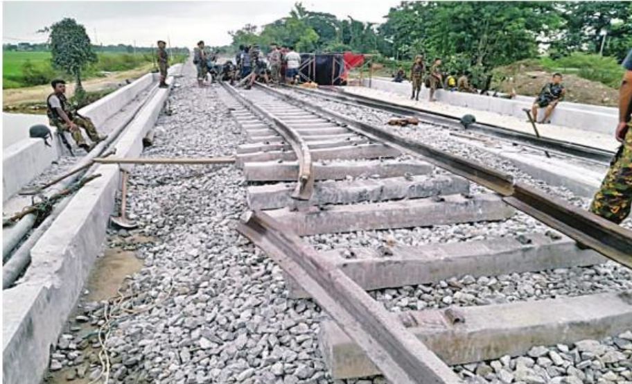
ရလိုင် ၁၈ ရက်တွင် အကြမ်းဖက် သောင်းကျန်းသူများ၏ ရက်စက်ကြမ်းကြုတ်စွာ ခိုင်းခွဲဖျက်ဆီးမှုကြောင့် ရန်ကုန်-မန္တလေး ရထားလမ်း အဆင့်မြှင့်တင်ရေး စီမံကိန်း၏ ဆောင်ရွက် ပြီးစီးနေသည့် ရထားလမ်း ထိခိုက် ပျက်စီးမှုအခြေအနေ အားတွေ့ရစဉ်။
