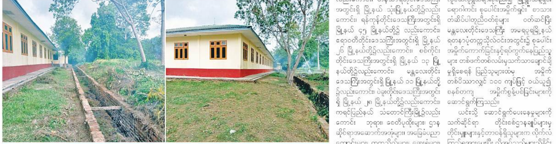
နေပြည်တော်ကောင်စီနယ်မြေ ပုဗ္ဗသီရိမြို့နယ် အမှတ်(၃)အခြေခံပညာအထက်တန်းကျောင်း၌ စုပေါင်းသန့်ရှင်းရေးဆောင်ရွက်မိ(ဝဲပုံ)နှင့် ဆောင်ရွက်ပြီး(ယာပုံ)ကို တွေ့ရစဉ်။
