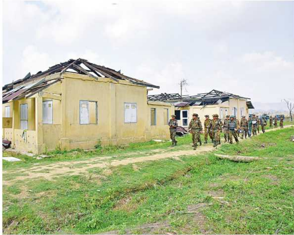
ညှိနှိုင်းကွပ်ကဲရေးမှူး (ကြည်း၊ ရေ၊ လေ) ဝိုင်းရံကြီးမောင်မောင်အေး တပ်ရင်း၊ တပ်ဖွဲ့များတွင် မှန်တိုင်းဒဏ်ကြောင့် ပျက်စီးခဲ့သည့် အဆောက်အအုံများကို လိုက်လံကြည့်ရှုစဉ်။
