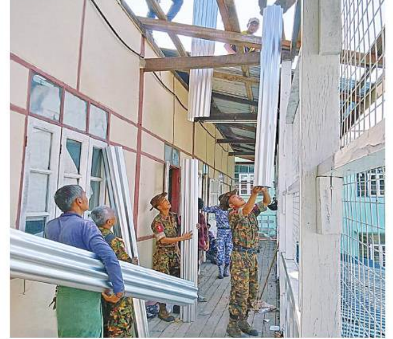
သဘာဝဘေးအန္တရာယ်ကျရောက်သောဒေသများတွင် တပ်မတော်မှ ကူညီကယ်ဆယ်ရေးအဖွဲ့များက ကူညီကယ်ဆယ်ရေးနှင့် ပြန်လည်ထူထောင်ရေးလုပ်ငန်းများ ပူးပေါင်းပါဝင်ဆောင်ရွက်ပေးစဉ်။
