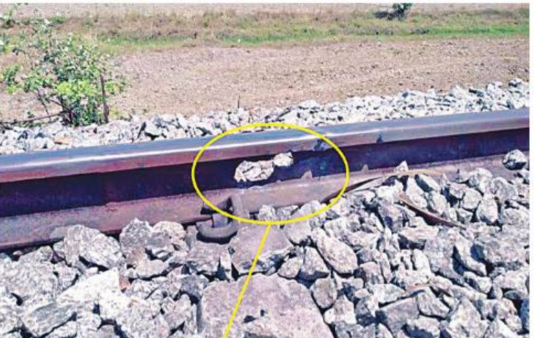
ဇင်းကျိုက်ဘူတာမှ ပုဇွန်တောင်ဘူတာသို့ ထွက်ခွာလာသည့် မြန်မာ့မီးရထား ကျောက်ရထားကို NUG၊ CRPH တို့၏ လက်ဝေခံ PDF အမည်ခံအကြမ်းဖက်သမားများက မိုင်းထောင်ဖောက်ခွဲပျက်ဆီးတိုက်ခိုက်မှုကြောင့် ရထားသံလမ်းထိခိုက်ပျက်စီးမှုမှတ်တမ်းဓာတ်ပုံ။
