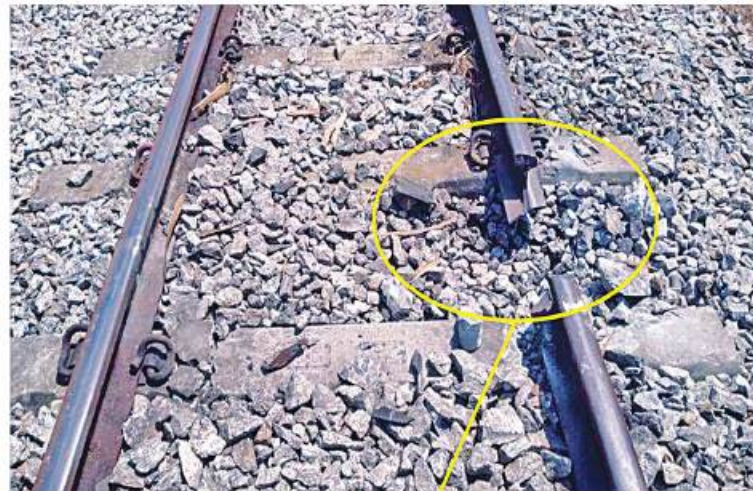
ဇင်းကျိုက်ဘူတာမှ ပုဇွန်တောင်ဘူတာသို့ ထွက်ခွာလာသည့် မြန်မာ့မီးရထား ကျောက်ရထားကို NUG၊ CRPH တို့၏ လက်ဝေခံ PDF အမည်ခံအကြမ်းဖက်သမားများက မိုင်းထောင်ဖောက်ခွဲပျက်ဆီးတိုက်ခိုက်မှုကြောင့် ရထားသံလမ်းထိခိုက်ပျက်စီးမှုမှတ်တမ်းဓာတ်ပုံ။
