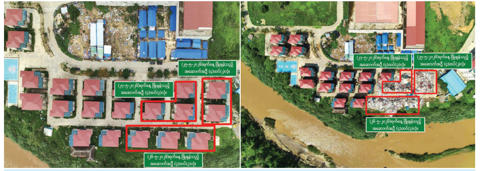
ကရင်ပြည်နယ် မြဝတီခရိုင် ရွှေကုက္ကိုလ်ဒေသ တရားမဝင်အဆောက်အအုံများကို မဖြိုဖျက်မီနှင့် ဖြိုဖျက်ပြီးစီးမှု မှတ်တမ်းဓာတ်ပုံ။
