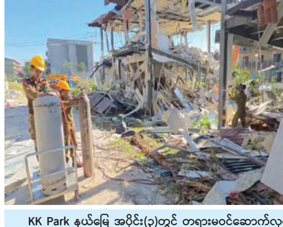
KK Park နယ်မြေ အပိုင်း(၃)တွင် တရားမဝင်ဆောက်လုပ်ထားသည့် နှစ်ထပ်တိုက် လူနေအဆောက်အအုံအား လေအိုး မီးအိုးဖြင့် ဖျက်ဆီးနေမှုကို တွေ့ရစဉ်။
