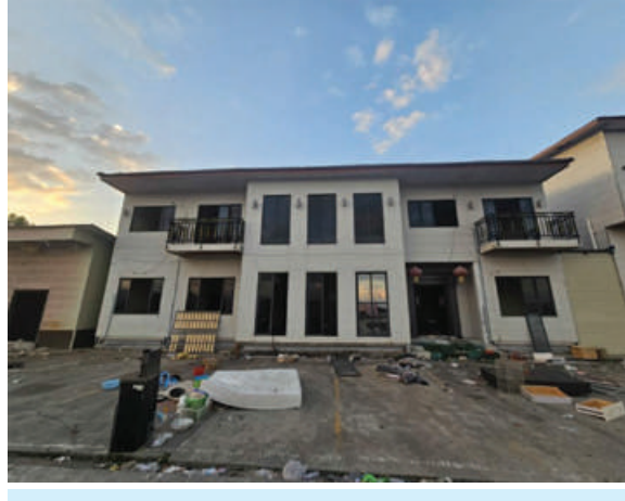
KK Park နယ်မြေ အပိုင်း(၃)တွင် တရားမဝင်ဆောက်လုပ်ထားသည့် နှစ်ထပ်တိုက် လူနေအဆောက်အအုံ မဖြိုဖျက်မီနှင့် ဖြိုဖျက်ပြီးစီးမှု မှတ်တမ်းဓာတ်ပုံ။
