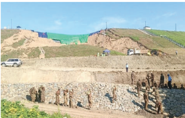
အနောက်တောင်တိုင်းစစ်ဌာနချုပ်မှ နယ်မြေခံတပ်မတော်သားများ၊ ဌာနဆိုင်ရာတာဝန်ရှိသူများက မမြရေလှောင်တံဆံဆင်ခြေလျှောမြေသားနိမ့်ကျမှုပြုပြင်ရေးလုပ်ငန်းများ ဆောင်ရွက်ကြစဉ်။
