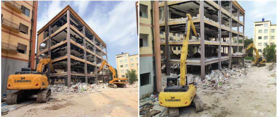
ရွှေကုက္ကိုလ်နယ်မြေ ဒုတိယပိုင်းအတွင်းရှိ အွန်လိုင်းလောင်းကစားမှုကျူးလွန်ရာတွင် အသုံးပြုခဲ့သည့် ငါးထပ်အဆောက်အအုံကို စက်ယန္တရားများဖြင့် စနစ်တကျဆက်လက်ဖြိုချဖျက်ဆီးမှုကိုတွေ့ရစဉ်။
