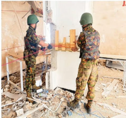
ရွှေကုက္ကိုလ်နယ်မြေ ဒုတိယပိုင်းအတွင်းရှိ အွန်လိုင်းလောင်းကစားမှုကျူးလွန်ရာတွင် အသုံးပြုသည့် ၁၃ ထပ် အဆောက်အအုံကို ယမ်းဖြင့်ယမ်းကပ်ခြင်းလုပ်ငန်းဆောင်ရွက်စဉ်။
