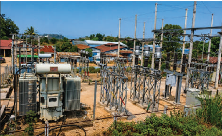
သီပေါမြို့နယ် ၃၃/၁၁ကေစီ ၁၀ အမ်စီအေ သီပေါဓာတ်အားခွဲရုံတွင် ပျက်စီးနေသော ဓာတ်အားခွဲရုံပစ္စည်းများ အသစ်အစားထိုးပြုပြင်တည်ဆောက်ခြင်း လုပ်ငန်းဆောင်ရွက်ပြီးစီးမှု မှတ်တမ်းဓာတ်ပုံ။
