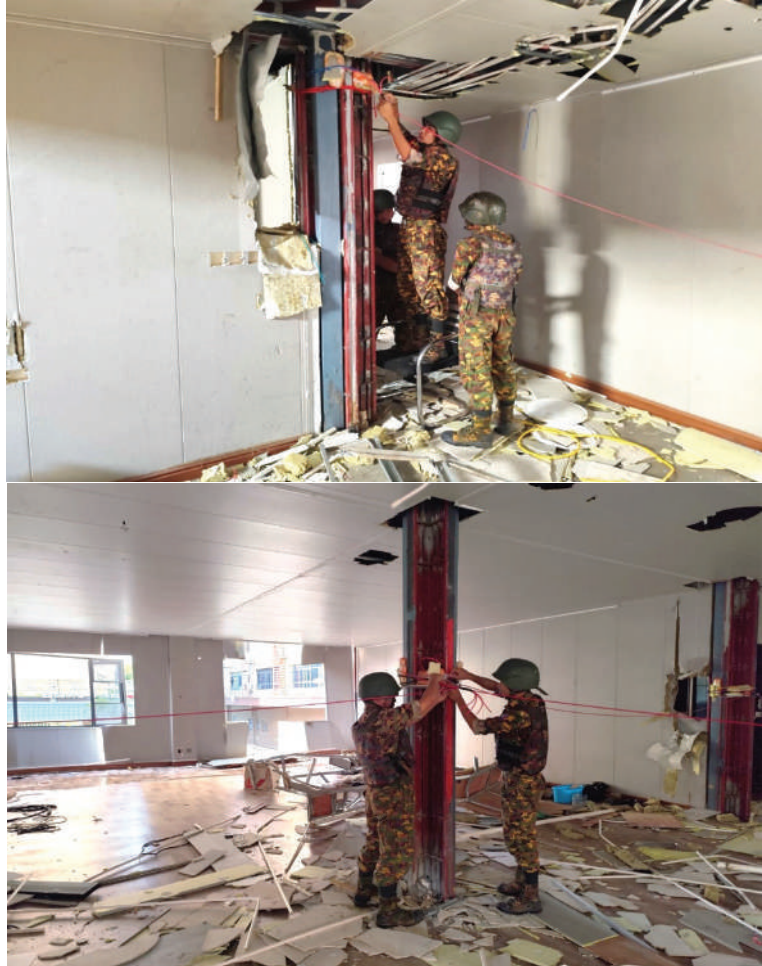
ကရင်ပြည်နယ် မြဝတီခရိုင် ရွှေကုက္ကိုလ်နယ်မြေရှိ အွန်လိုင်းလိမ်လည်လောင်း ကစားမှုလုပ်ကိုင်ခဲ့သည့် တရားမဝင် ခုနစ်ထပ် လူနေအဆောက်အအုံကို ယမ်းဖြင့် ဖောက်ခွဲဖျက်ဆီးရန် ပြင်ဆင်နေစဉ်။
