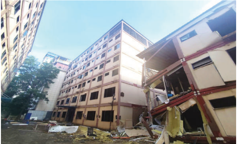
ကရင်ပြည်နယ် မြဝတီခရိုင် ရွှေကုက္ကိုလ်နယ်မြေရှိ အွန်လိုင်းလိမ်လည်လောင်းကစားမှုလုပ်ကိုင်ခဲ့သည့် တရားမဝင် ခုနစ်ထပ်လူနေအဆောက်အအုံကို မဖြူဖျက်မီ တွေ့ရစဉ်။
