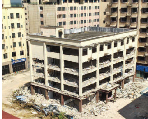
ရွှေကုက္ကိုလ်နယ်မြေ ဒုတိယပိုင်းအတွင်းရှိ အွန်လိုင်းလောင်းကစားမှု ကျူးလွန်ရာတွင် အသုံးပြုခဲ့သည့် ငါးထပ် အဆောက်အအုံ စနစ်တကျဆက်လက်ဖြိုချဖျက်ဆီးထားမှုကိုတွေ့ရစဉ်။
