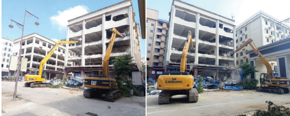
ရွှေကုက္ကိုလ်နယ်မြေ ဒုတိယပိုင်းအတွင်းရှိ အွန်လိုင်းလောင်းကစားမှု ကျူးလွန်ရာတွင် အသုံးပြုခဲ့သည့် ငါးထပ် အဆောက်အအုံကို စက်ယန္တရားများဖြင့် စနစ်တကျဆက်လက်ဖြိုချဖျက်ဆီးမှုကိုတွေ့ရစဉ်။
