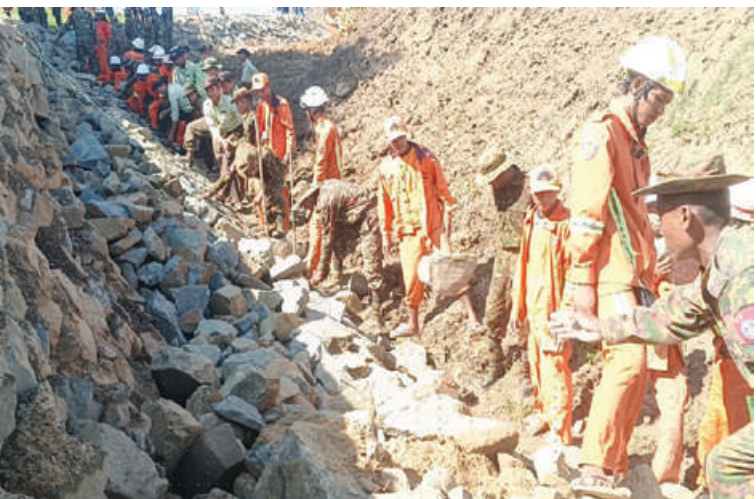
အနောက်တောင်တိုင်းစစ်ဌာနချုပ်မှ နယ်မြေခံတပ်မတော်သားများ၊ ဌာနဆိုင်ရာ များ၊ ဒေသခံပြည်သူများက မမြရေလျှောင့်တမံဆင်ခြေလျှောမြေသားနိမ့်ကျမှု ပြုပြင် ရေးလုပ်ငန်းများ ဆောင်ရွက်ကြစဉ်။
