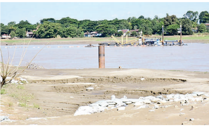
တာအိကျခြင်းနှင့် ရေကြီးရေလျှံမှုများ မဖြစ်ပေါ်စေရေး သက်ဆိုင်ရာဌာနများက မြစ်ကြောင်းများ ကောင်းမွန်ရေး သောင်တူးခြင်းလုပ်ငန်း ဆောင်ရွက်နေစဉ်။
