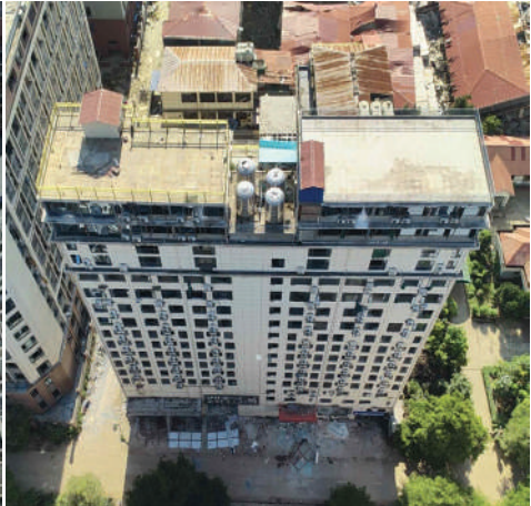
ရွှေကုက္ကိုလ်နယ်မြေ ဒုတိယပိုင်းအတွင်းရှိ အွန်လိုင်းလောင်းကစားမှုကျူးလွန်ရာတွင် အသုံးပြုသည့် ၁၃ ထပ် အဆောက်အအုံကို စနစ်တကျဖောက်ခွဲ၍ဖြိုချဖျက်ဆီးပြီးစီးမှုကို တွေ့ရစဉ်။
