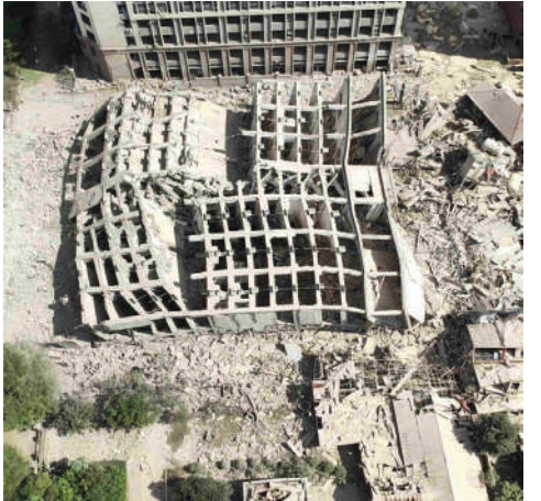
ရွှေကုက္ကိုလ်နယ်မြေ ဒုတိယပိုင်းအတွင်းရှိ အွန်လိုင်းလောင်းကစားမှုကျူးလွန်ရာတွင် အသုံးပြုသည့် ၁၃ ထပ် အဆောက်အအုံကို စနစ်တကျဖောက်ခွဲ၍ဖြိုချဖျက်ဆီးပြီးစီးမှုကို တွေ့ရစဉ်။
