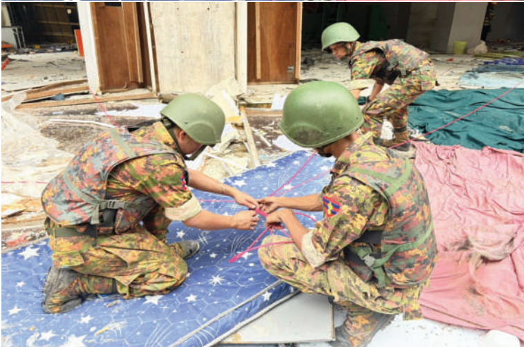
ရွှေကုက္ကိုလ်နယ်မြေ ဒုတိယပိုင်းအတွင်းရှိ အွန်လိုင်းလောင်းကစားမှု ကျူးလွန် ရာတွင် အသုံးပြုသည့် တရားမဝင်အဆောက်အအုံများကို ယမ်းဖြင့် စနစ်တကျဖြိုချ ဖျက်ဆီးရန် ပြင်ဆင်နေမှုကိုတွေ့ရစဉ်။
