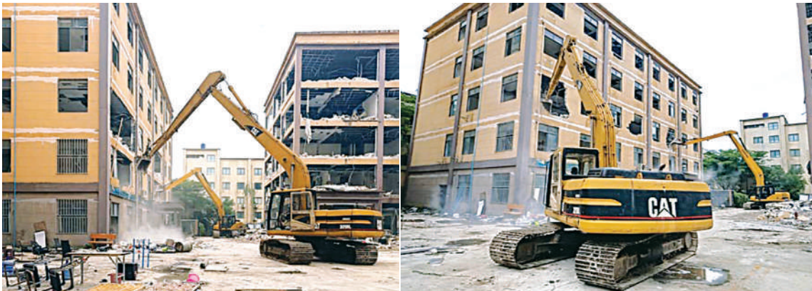
ရွှေကုက္ကိုလ်နယ်မြေ ဒုတိယပိုင်းအတွင်းရှိ အွန်လိုင်းလောင်းကစားမှုကျူးလွန်ရာတွင် အသုံးပြုသည့် တရားမဝင်အဆောက်အအုံများကို စက်ယန္တရားများဖြင့် စနစ်တကျဖြိုချဖျက်ဆီးနေမှုမှတ်တမ်းဓာတ်ပုံ။
