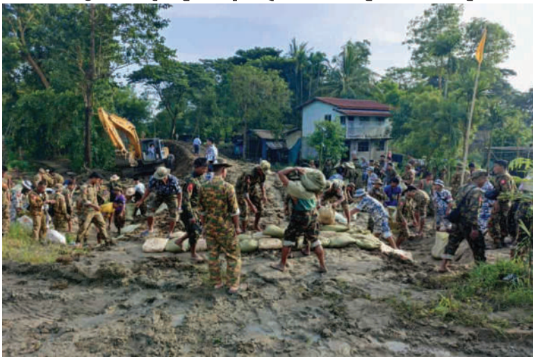
နယ်မြေခံတပ်မတော်သားများ၊ ဒေသခံပြည်သူများက ညောင်တုန်းကျွန်းတာ(ရောဝတီမြစ်ခွဲ) တာကိုယ်ထည်တိုက်စားခံရမှု တားဆီးကာကွယ်ရေးလုပ်ငန်းများ ဆောင်ရွက်ကြစဉ်။
